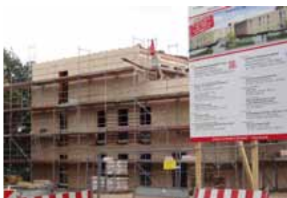
Richtfest beim Erweiterungsbau Kinderhauses in Lübeck
